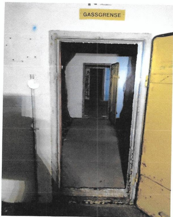
Gass sluse, takhøyde 3,3 m Dører H 1,8 m, B 0,8 m Bilde 10
