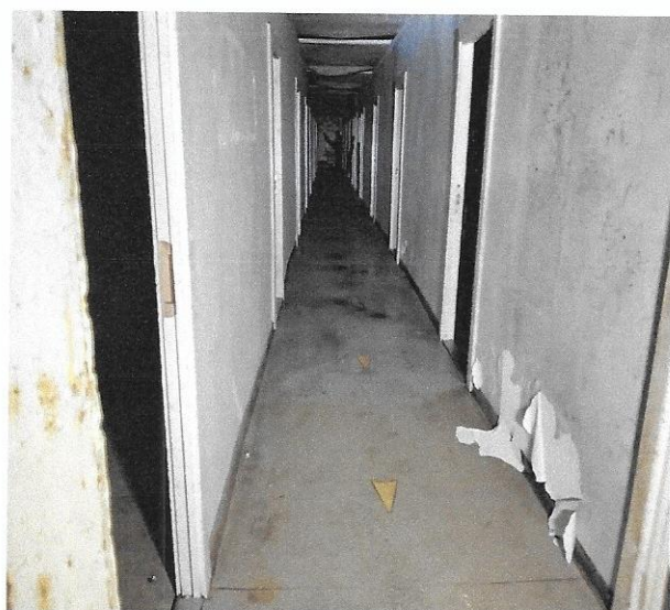
Korridor til forlegningsrom, Takhøyde 2,50 m til løs himling. Bilde 16
