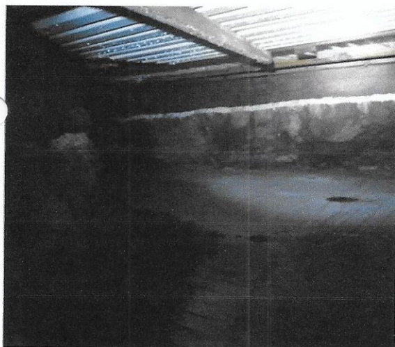
Dekningsrom bak kanonstandplass, etter detonasjonssluse Bilde 12
