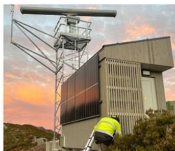
Bilde 5 –Instrumentbod ledd inn med sibirsk lerk
