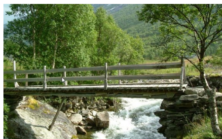
Brua over Grøa ved setra
