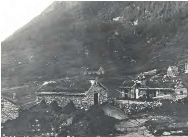
Gamle fotos tatt mens fjøset sto. Fjøst er lengst bak (bilde t.v.), mellom personene (t.h). her vises takvinkel og konstruksjon med laft i trekanten mot taket i gavlene.
