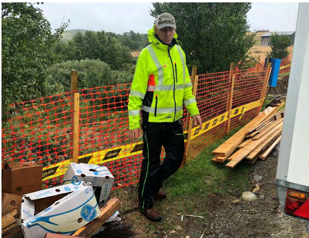
Bildet viser fangstgrop med id 12046-70. Jostein Bergstøl (KHM) står på vollen til gropa. Gjerdet er plassert på vollen sammen med materialer og diverse. Det er gravd og gruset helt inn i vollen. Bildet er tatt mot NØ.
