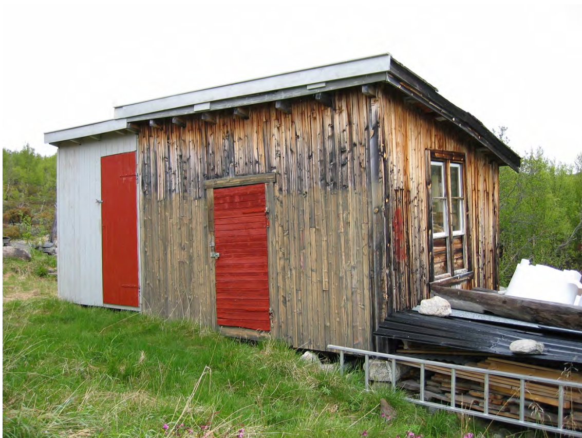
Bilde 2 Uthus ved hytta til Stein Herzog. Bildet er tatt i 2004.
