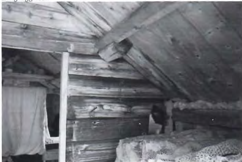
Tilbygg ved inngang, enkel tetting med byggsaum.
