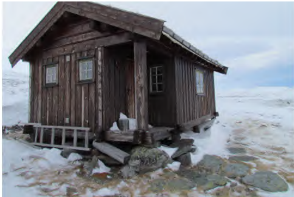
Hemtjønnbua slik den var opprinnelig
