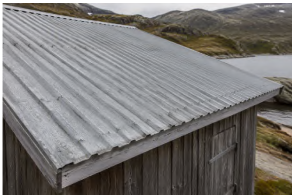
Eksempel på galvanisert bølgeblekk tak etter flere år med vær og vind.
