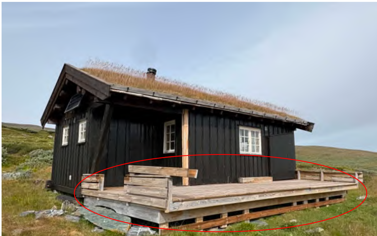
Fig. 2: Hemtjønnsbua der rød sirkel viser platting og rekkverk som pålegges fjernet.
