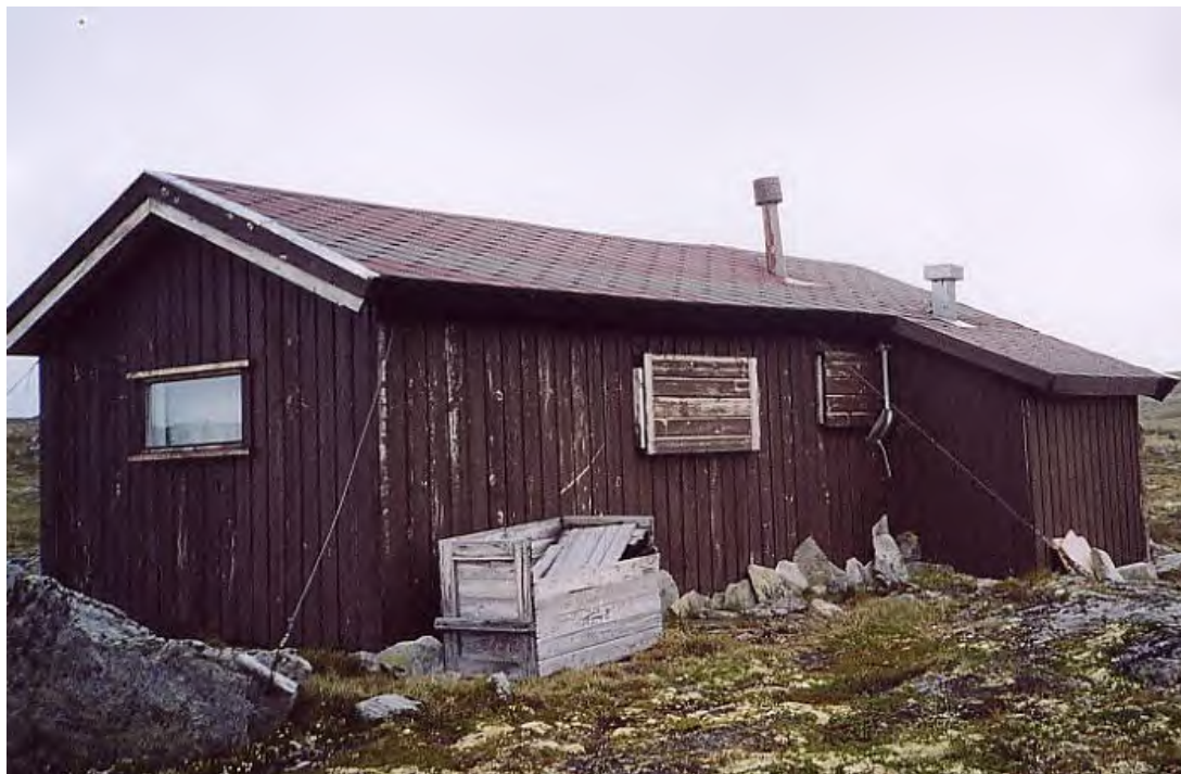
Figur 3. Bilde av eksisterende hytte
