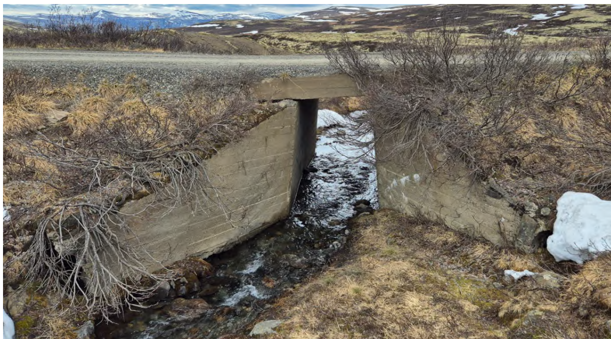
Figur 2. Dagens Depljtønna bru.
