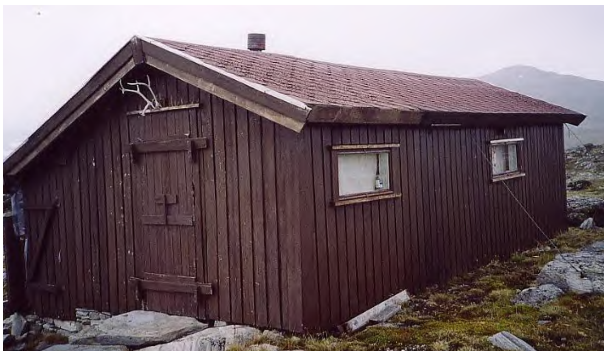
Figur 4. Bilde av eksisterende hytte
