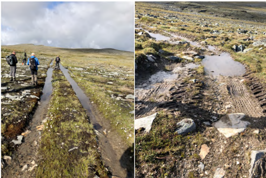
Enkelte deler av traseen er også fuktig og preget av erosjon.
