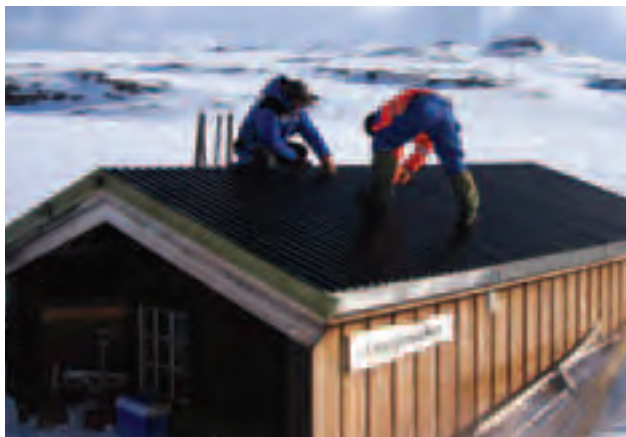
Vedlikehold av tak.
