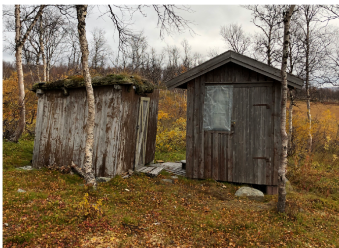
Eksisterende to uthus - høst 2015
