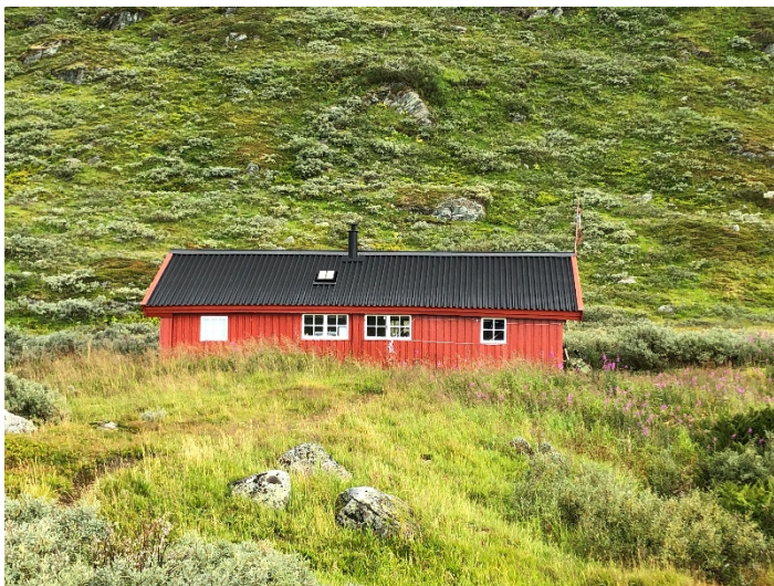
Jengelhytta sett fra eksisterende utedo som søkes erstattet med nytt bygg med samme plassering
