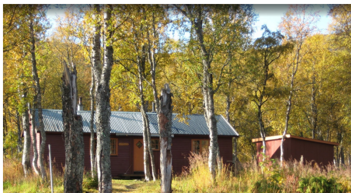
Orvasshytta ligger i storvokst tett bjørkeskog på sørsiden av Orvatnet. Sør for hytta er det fjellpartier som skjermer for solen i deler av året. Bildet viser nordsiden av hytta, solpanelet skal monteres på motsatt side og vil ikke blir synlig fra hyttens framside.
