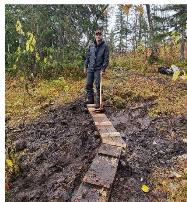
Rehabilitering og sklisikring av kloppe på Namsskrokstien 2025
