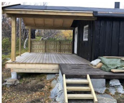
2020 – platting i forkant er ikke fjernet, det er etablert trapp opp til denne plattingen
