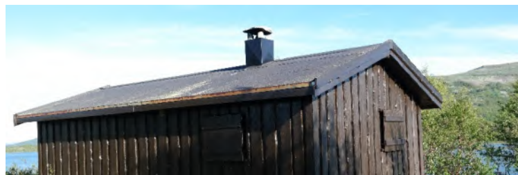
Bilde fra 2015 som viser tak og takteking
