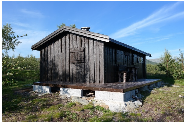
Bilde av hytte tatt i 2015 med platting mot sør og vest
