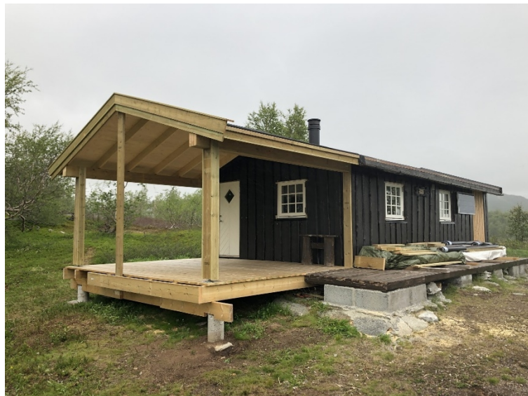
Bilde av hytte tatt i 2020 med gulv under takutstikk. Rekkverk er ennå ikke satt opp.
