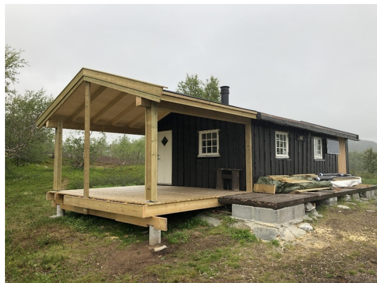
Bilde av hytte tatt i 2020 med gulv under takutstikk. Rekkverk er ennå ikke satt opp.
