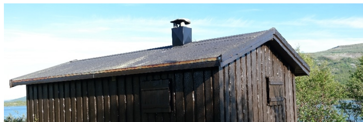
Bilde fra 2015 som viser tak og takteking
