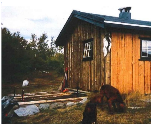
Udatert bilde som viser tidligere konstruksjon som ble fjernet til erstatning for tidligere platting
