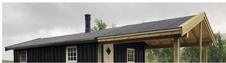
Bilde fra 2020 hvor det ser ut til at taket ikke er skiftet eller hevet. Ny pipe er satt opp, det er satt inn nytt vindu på nordøstre hjørne (til venstre på bildet). Takoverbygg er satt opp jfr. innvilget dispensasjon.
