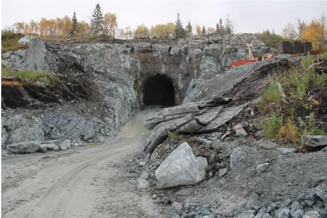
Omløpstunnelen i 2015. Foto tatt av Fylkesmannen i Nord-Trøndelag.
