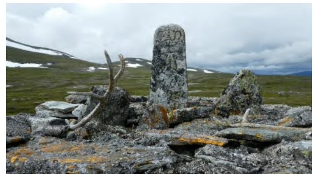
Grenserøysene har form av avskårne kjepler, rundt 1,5 meter høye, rundt to meter brede i bunnen og en halv meter smalere øverst. I toppene er det murt inn opptil en meter høye steinplater (hjertersteiner) med innhugd nummer, byggeår og kongenavn. Bilde av grenserøys 206
