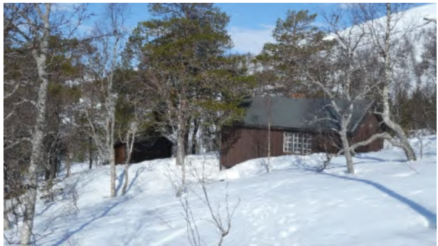
Vegg mot sør hvor det planlegges å sette inn ekstra vindu. Til venstre for hytta vises uthuset som skal flyttes til høyre for hytte. Det vil si at uthuset blir mindre dominerende enn i dag.
