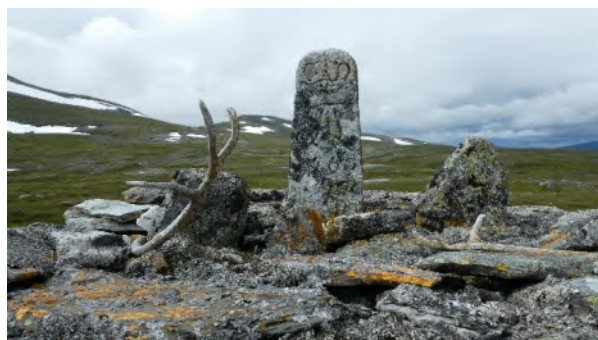
Grenserøysene har form av avskårne kjepler, rundt 1,5 meter høye, rundt to meter brede i bunnen og en halv meter smalere øverst. I toppene er det murt inn opptil en meter høye steinplater (hjertersteiner) med innhugd nummer, byggeår og kongenavn. Bilde av grenserøys 206
