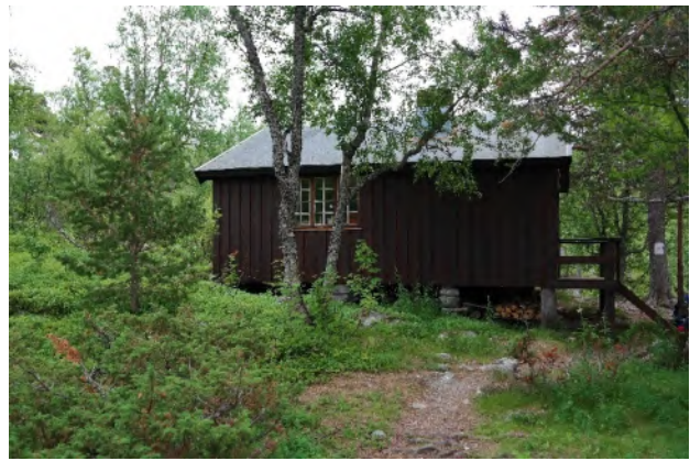
Nordre vegg, uthus med nytt utedo er planlagt satt opp til venstre for bildets ytterkant.
