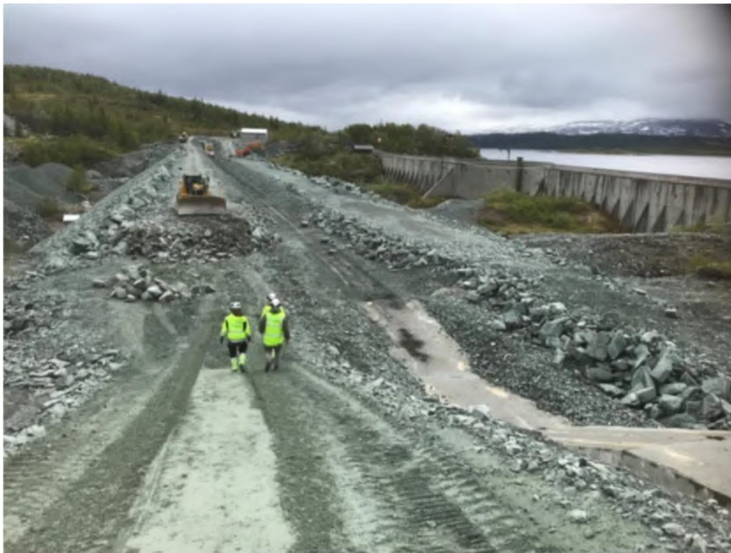
Bygging av ny Namsvassdam. Foto tatt 7.6.2018 av Fylkesmannen i Trøndelag.
