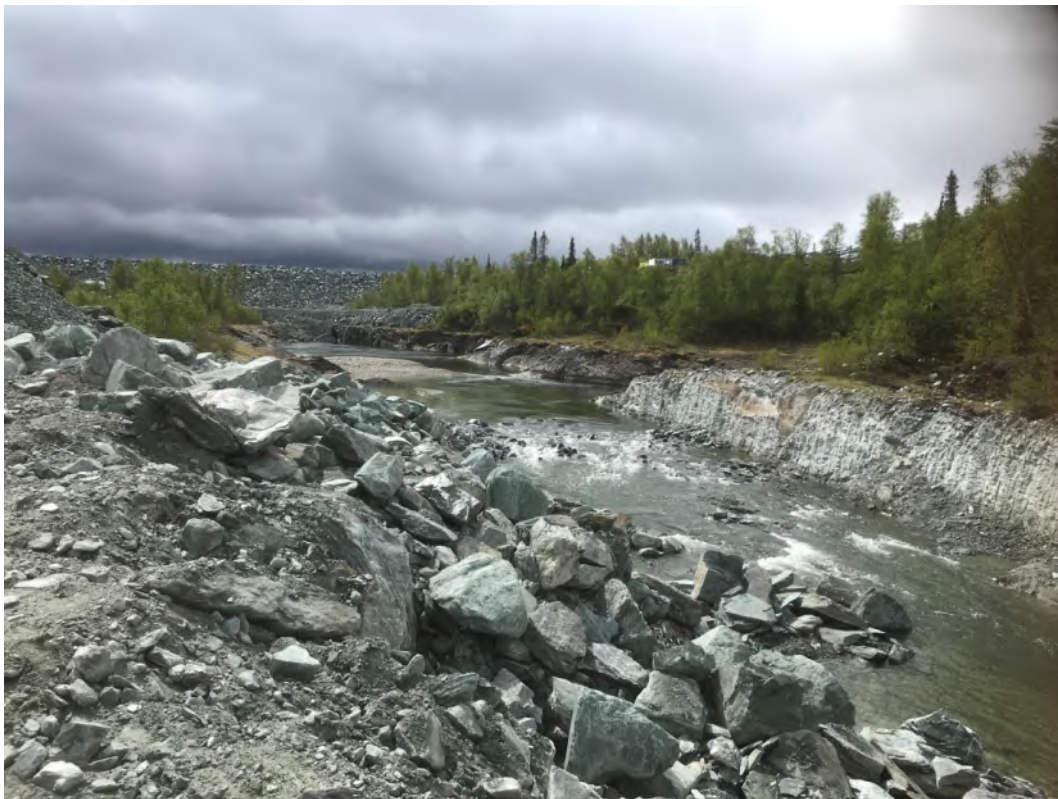
Utsprengt kanal nedstrøms ny dam. Foto tatt 7.6.2018 av Fylkesmannen i Trøndelag.
