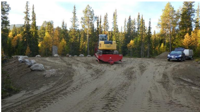
Etablering av ny innfallsport august 2016. Foto Tore Tødås
