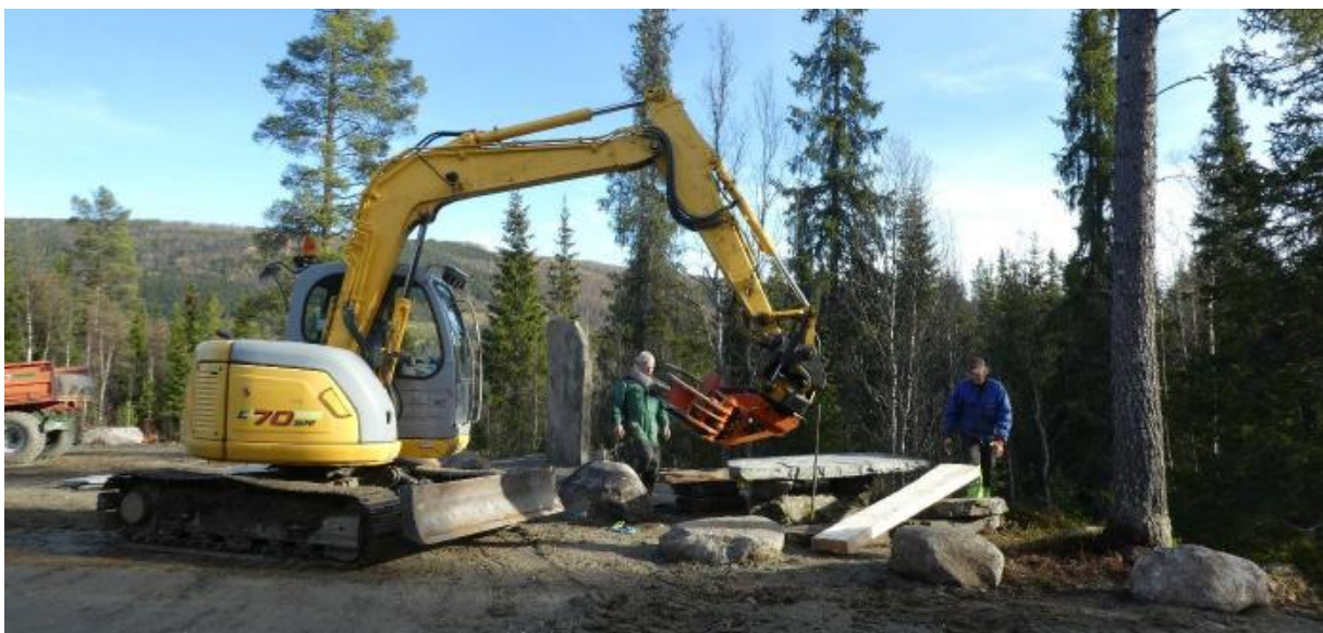
Bygging av benker og bord i skifer og furuplank. Det er valgt solide løsninger som krever forholdsvis lite vedlikehold. Foto: Tore Tødås
