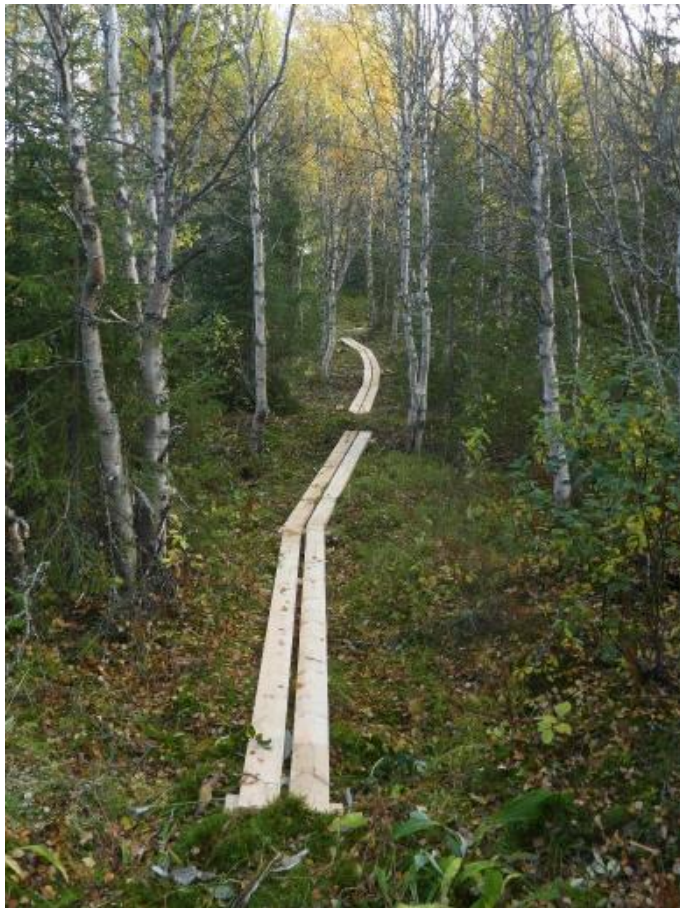
Ny tilførselssti som er ryddet og klopplagt. September 2016. Foto: Tore Tødås
