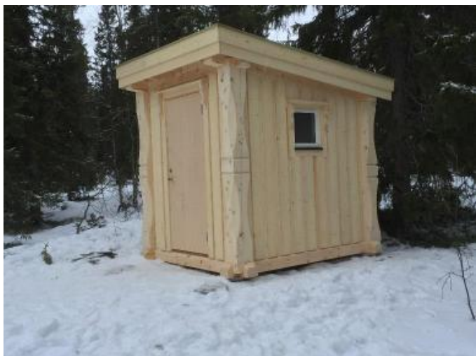
Toalett bygd ihht krav til universell utforming. Foto: Øyvind Ness
