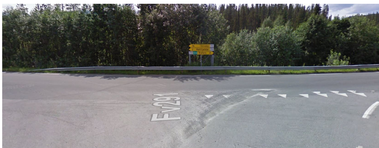
Kryss med gjeldende skilting, sett fra FV 291
