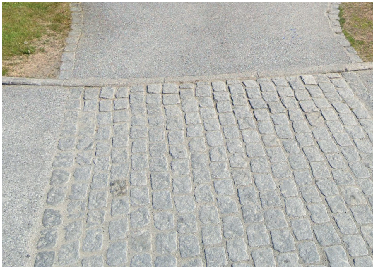
Bildet viser smågatestein som er brukt til fotgjengeroverganger i Skjolden sentrum
