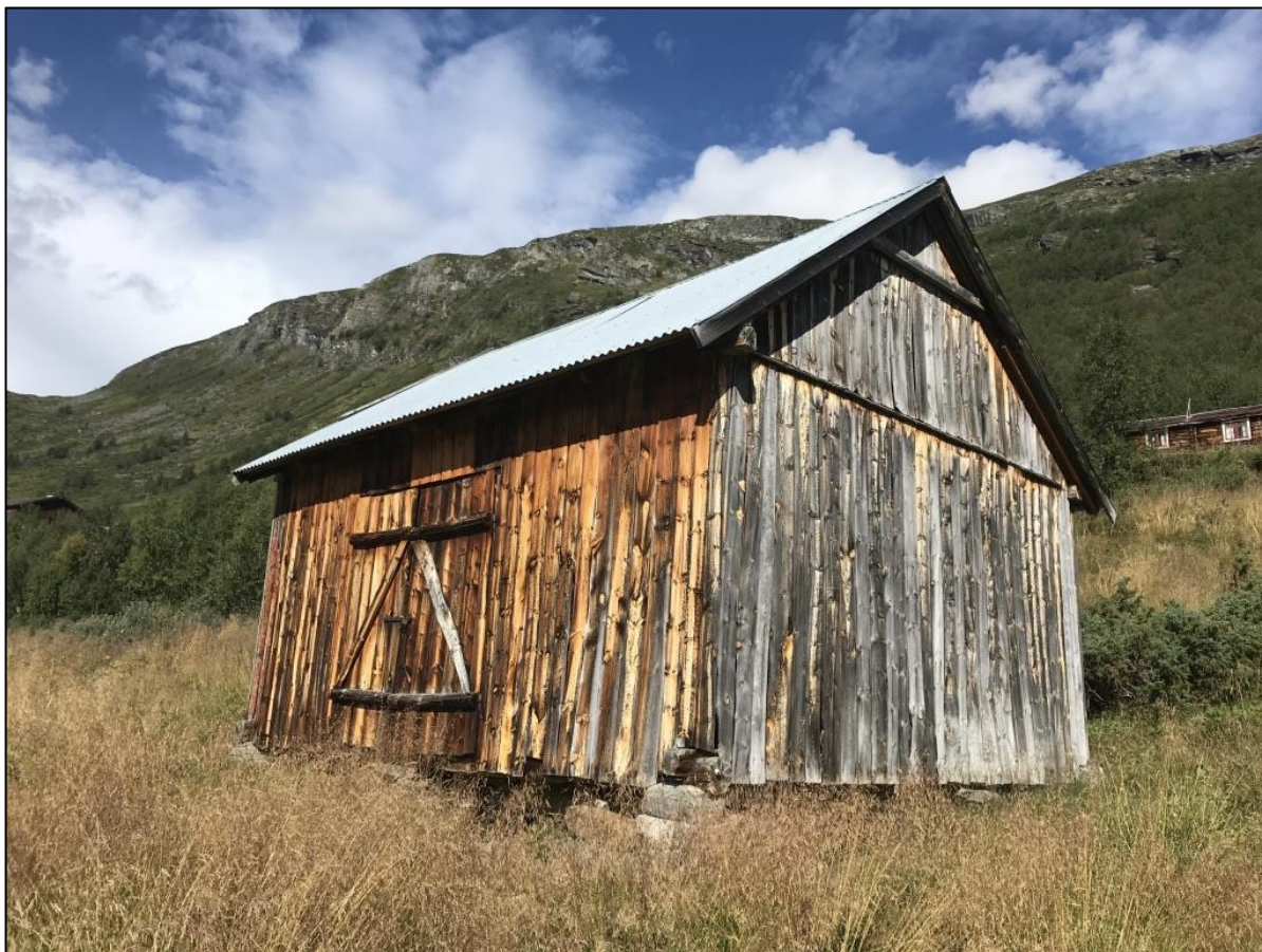
Figur 2. Alle bygningar i Høydalen vart dokumentert med bilete frå 8 vinklar rundt heile bygninga. Her hjørne sidevegg/gavlvegg på løe nedanfor Høydalsæter. Foto: Bjørn Harald Larsen.
