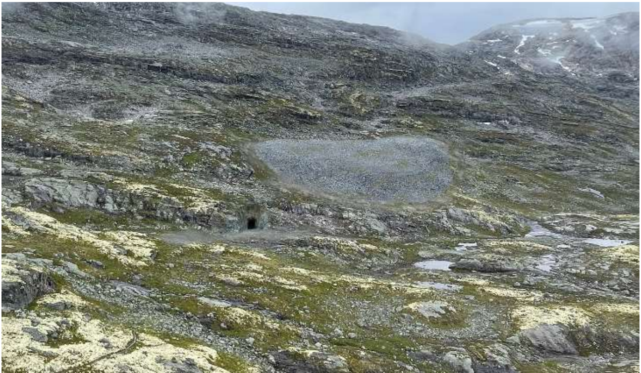
Figur 2-1: Fotovisualisering av hvordan portal og deponi i Nørdstedalen kan se ut etter ca. 10 år.
