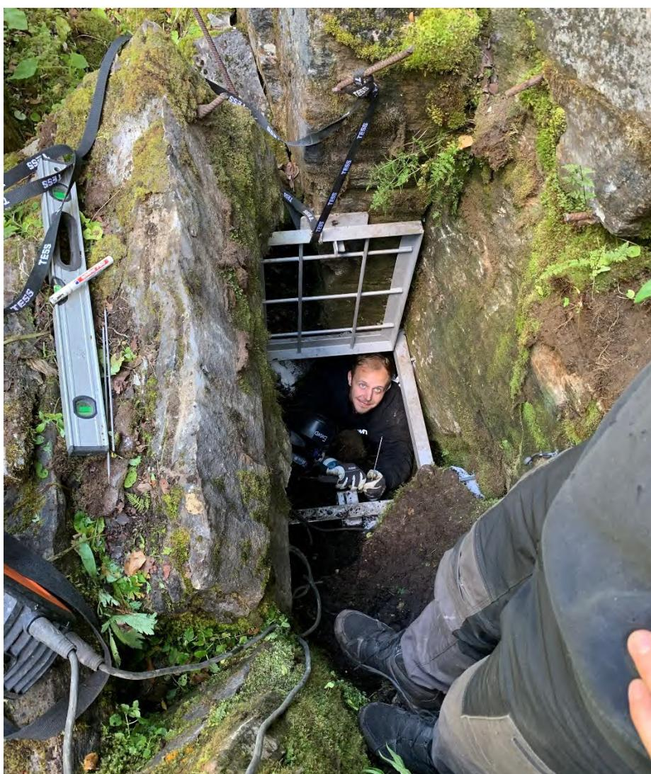
**Figur 22.** Montering av nye grotteporter i Rana («prosjekt grotteporter» ved Statsforvalteren i Nordland). Ny port i sandblåst, rustfritt stål. Materialet er solid og med matt farge som med videre anløpning passer fint mot natur og grå kalkstein. Låskasse for hengelås ved personens hånd, fjellveggen bak skal forsynes med en hekte som kan holde porten åpen under bruk.
