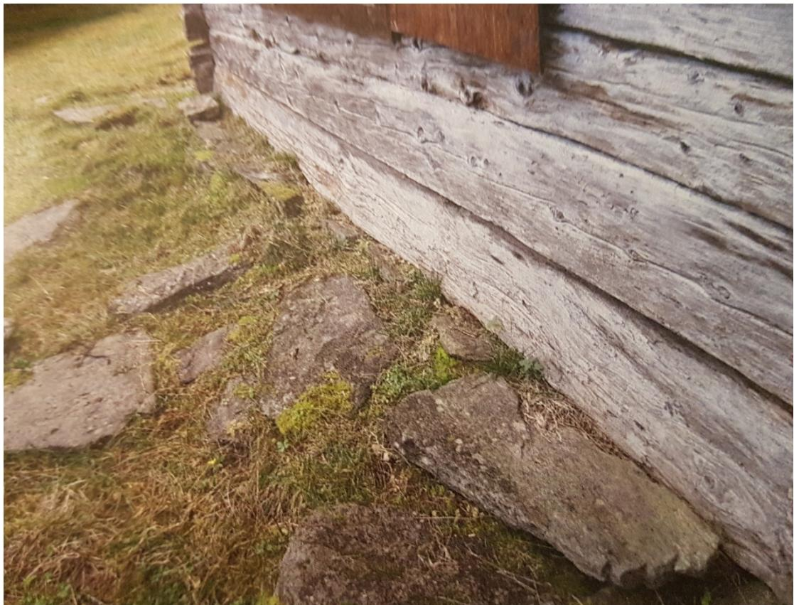
Figur 3: Nedste delen av laftetømmeret byrjar å bli dårlig pga fukt
