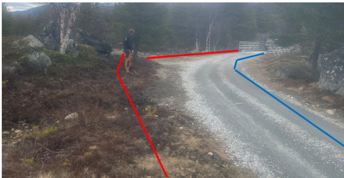
Vegetasjon og masse blir fjerna på høgre sida av den raude streken. På høgre sida av den blå streken blir det plassert stein eller laga ei grøft.
