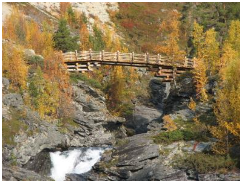
Den nye utleggsbrua over Tora frå 2008.
