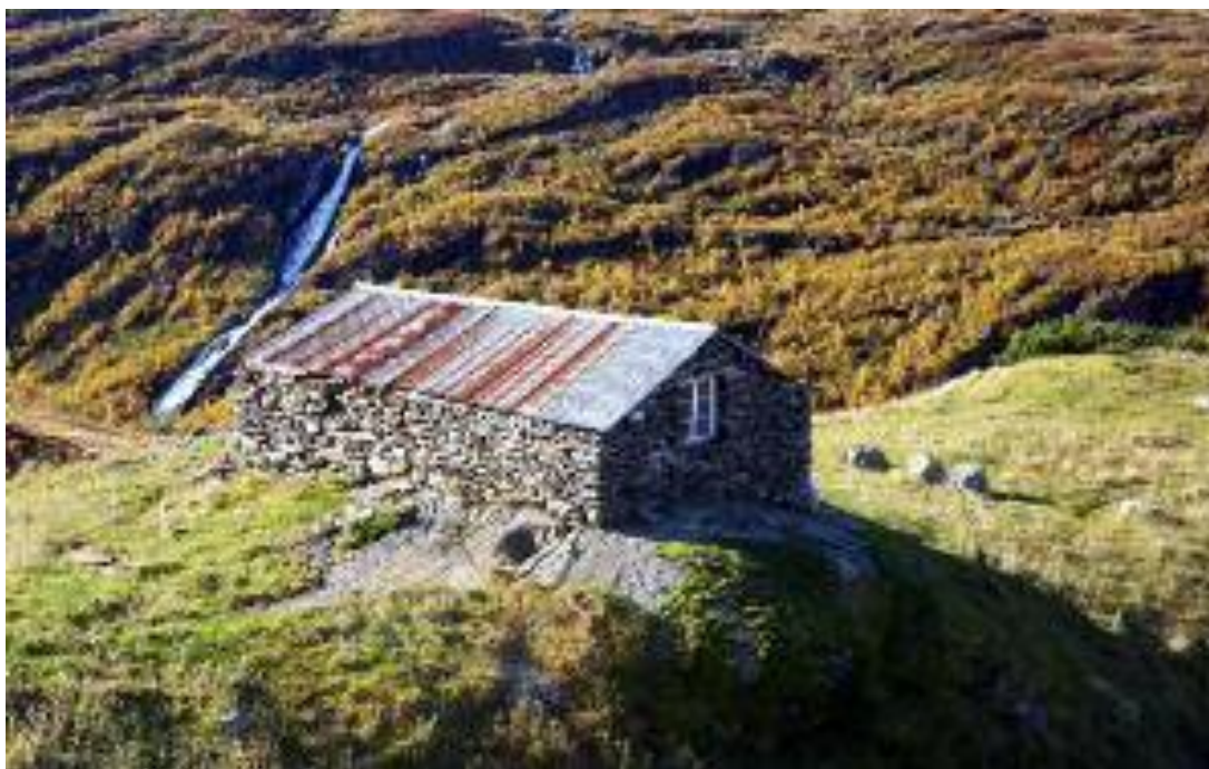
Stølen Nobbi (20/5) er svært gammalt. Både sel og skot er mura, men selet er i nyare tid kledd med treverk innvendig. Frå gammalt av var det torvtak på selet og tak av naturheller på skotet. Nedanfor selet ligg samlingsstaden for budeiene: Søndagshaugen. Her er ein tørr og fin haug med godt utsyn. Nærare selet er det groper i berget. Dette kan vera offergroper (Rapport 2-2008: Stølane i Mørkridsdalen). Foto: Vatne Vision.
