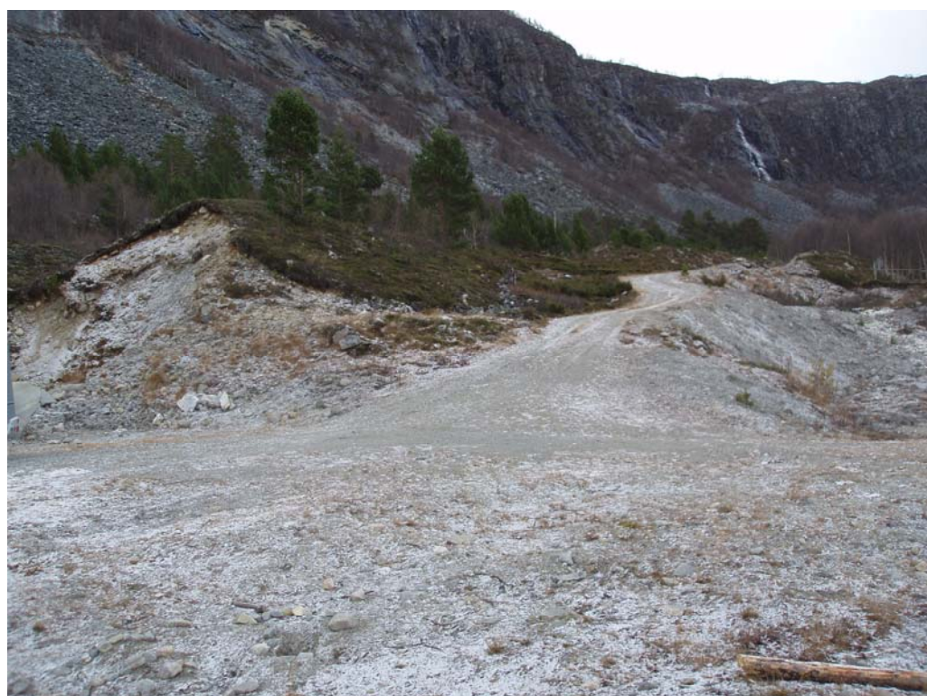
Fig. 5. Oversiktsbilde over eksisterende massetak ved Baksiddebrennsætra.
