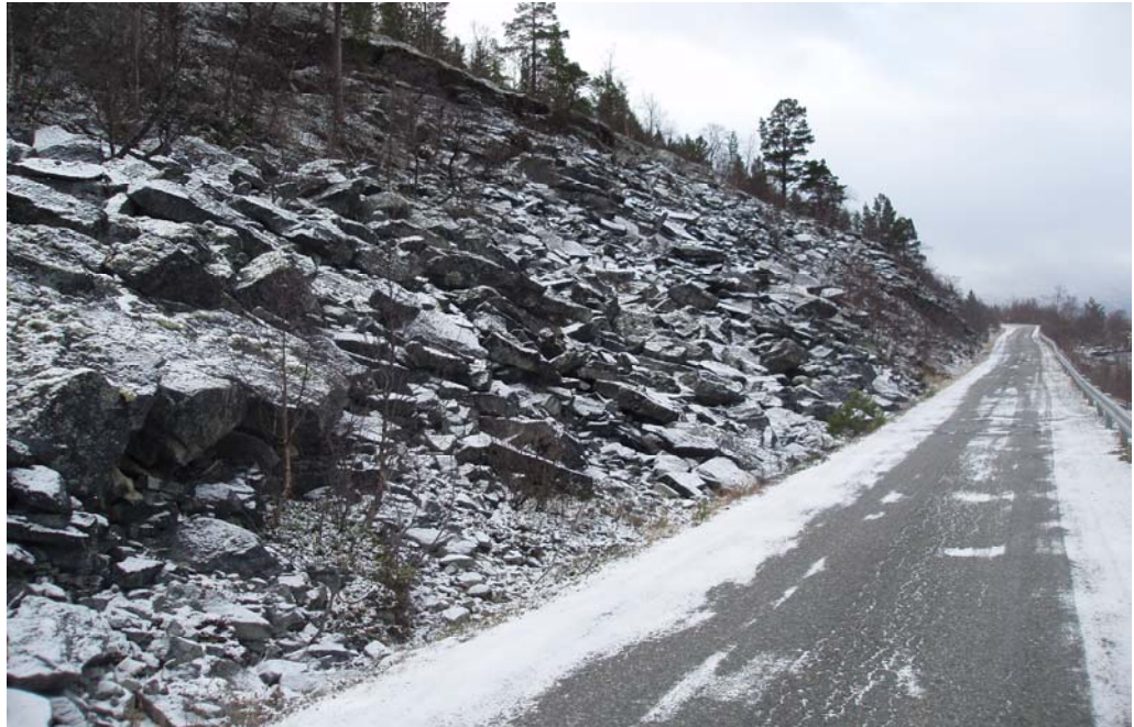
Fig. 3. Bilde som viser karakteren av ura i Kleivberget. Det fremgår av bildet at ura inneholder mye stor stein som må pigges før knusing.
