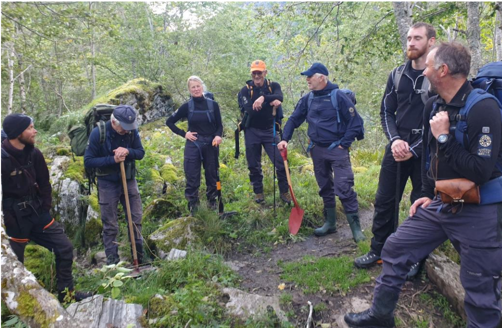
Figur 36. SNO stilte med mange folk, med tenesteytarar frå Lom fjellstyre og Skjåk almenning, på arbeidet med å rydde ved Knivabakkbrui og bruke materialet til klopplegging av myra før brua.
