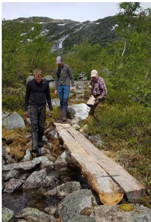
Figur 40. Nye klopper på plass.
