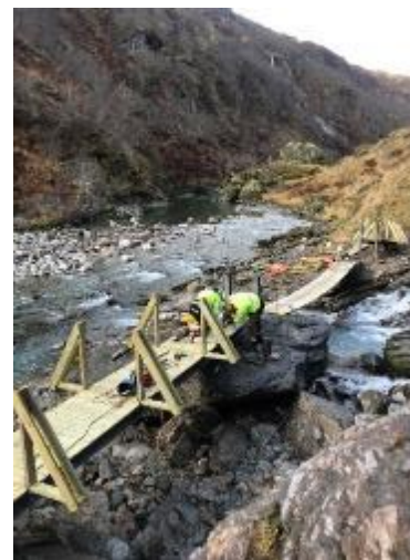
Figur 33 Skjolden bygdeservice i arbeid med ny bru ved Fossen. Foto: Trygve Snøtun
