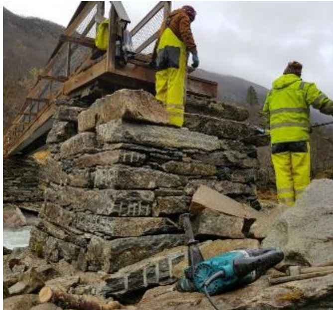
Figur 31 Bygging av nytt bru-kar, eit samarbeid mellom Ødegård bygg og maskin og Stibbyggjaren. Foto: Rune Fuglesteg
