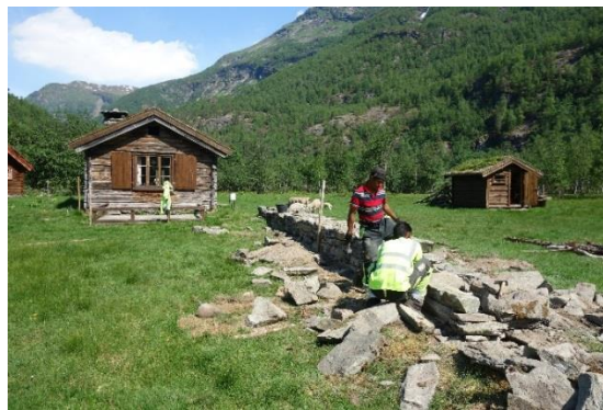
Figur 46. Sherpaer restaurerar muren på Dulsete.
