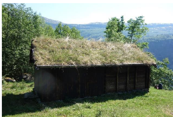
Figur 11. Kontroll av oppfølging av vilkår avdekket ingen avvik på stølshuset på Beget.
