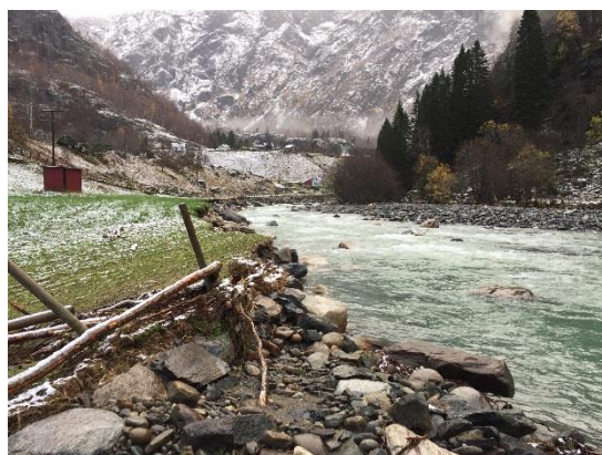
Figur 16 ..og har vaska vekk bilvegen inn til verneområdet
