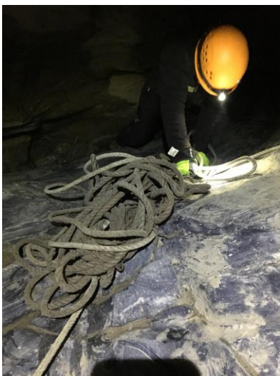
Figur 41. Fjerning av tauverk.
