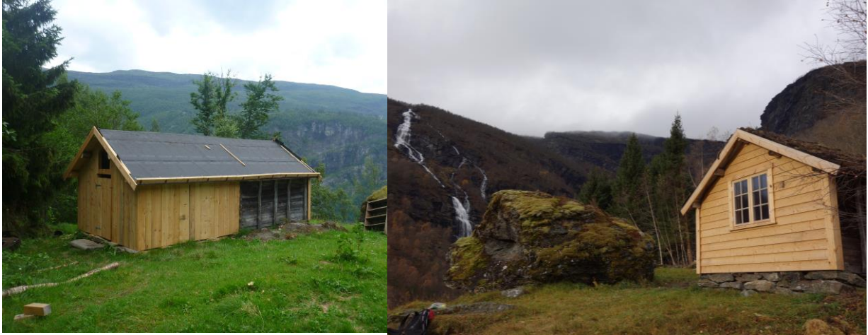
Figur 26. Det nyrestaurerte stølshuset på Berget i Mørkridsdalen.
