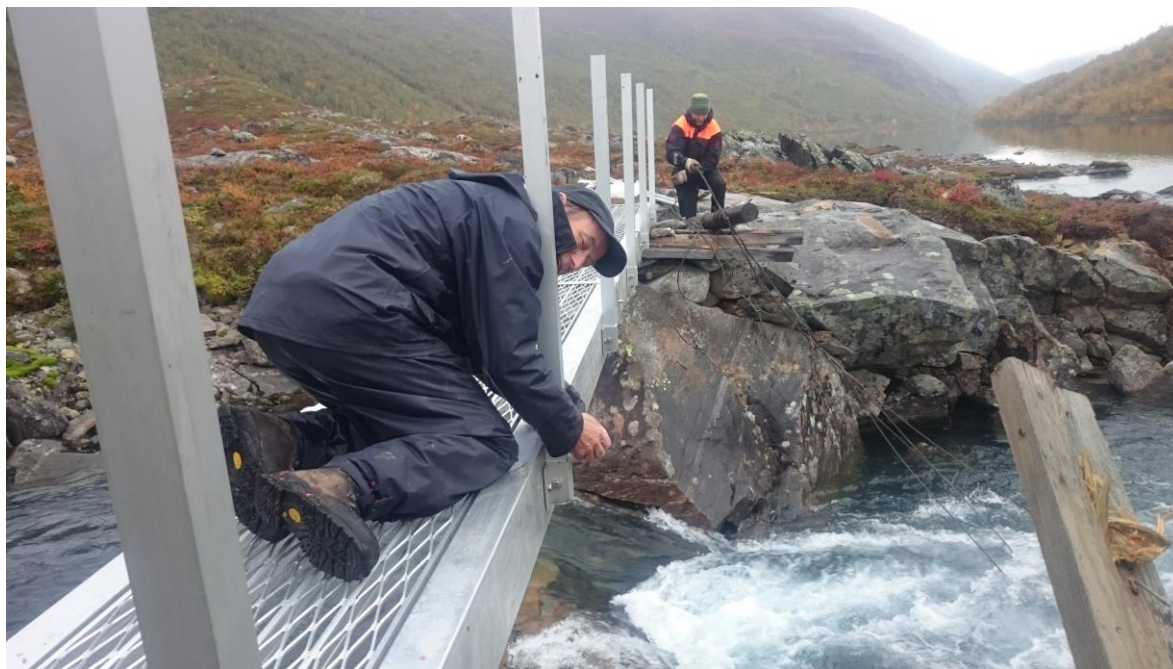
Figur 30. Under arbeidet med monteringa av nybrua.
