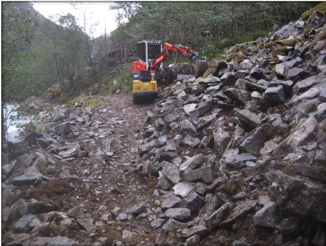
Drageset Maskin utfører utbedringer på buføringsveien i Mørkridsdalen
