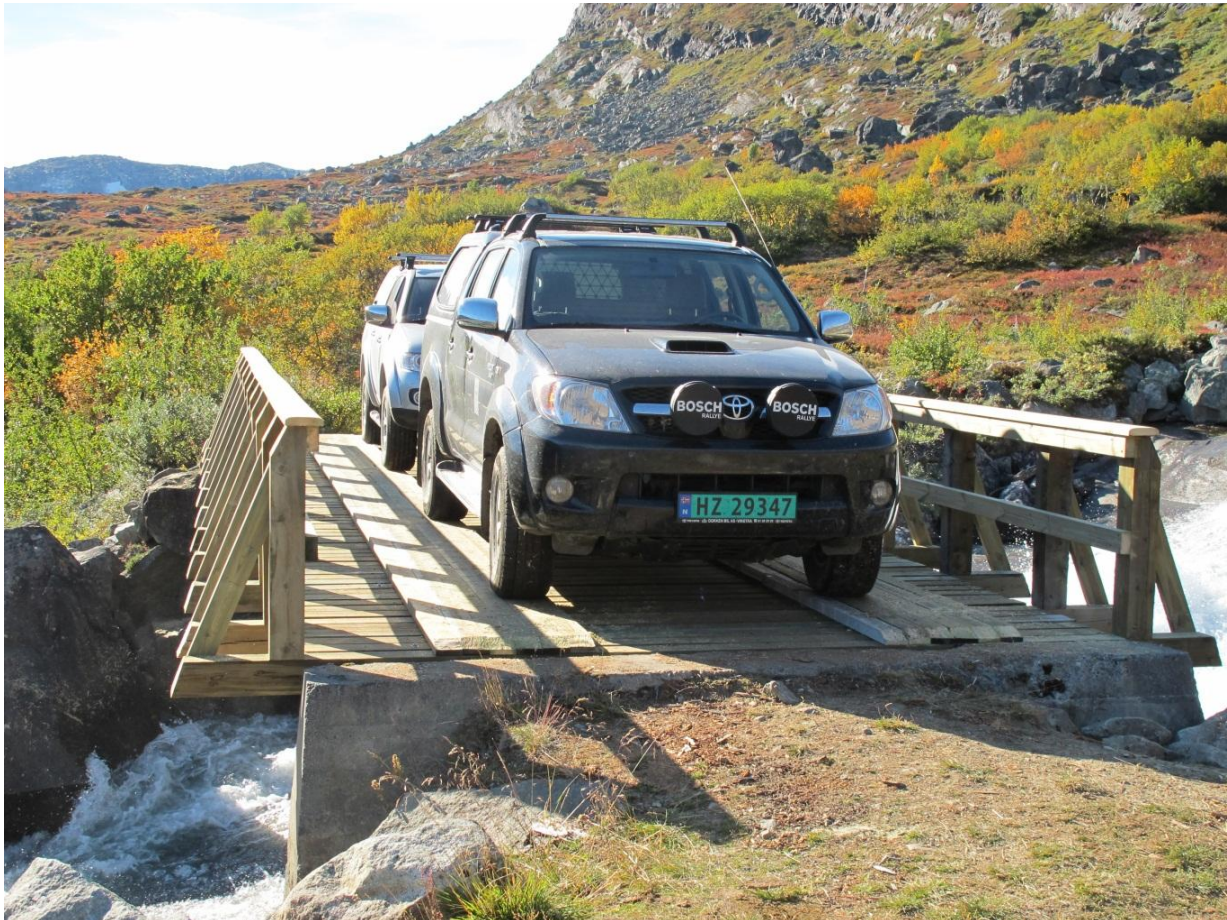
Figur 21. Etter utskifting av material.
