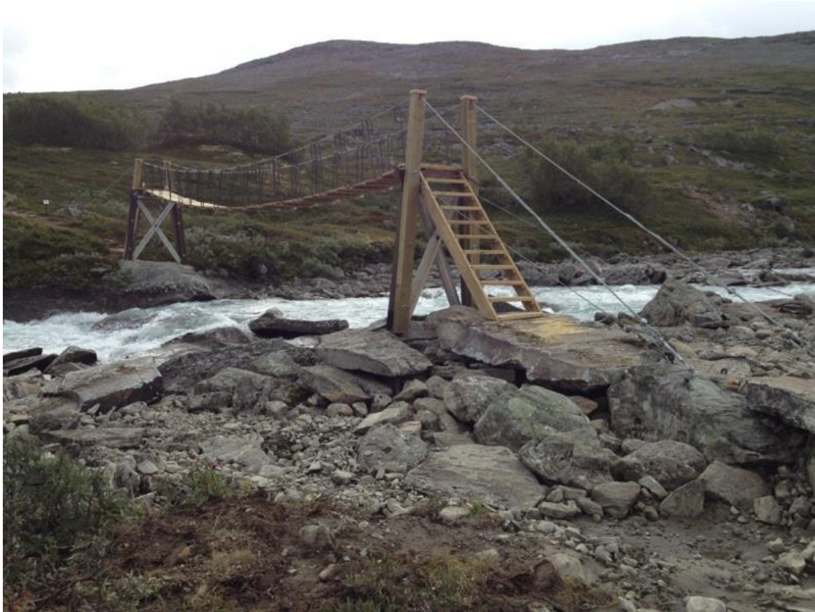
Figur 24. Den nye brua over Måråe.
