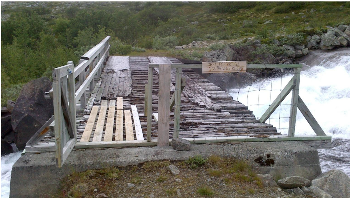
Figur 20. Den gamle brua over Høya i Bukkebotn..
