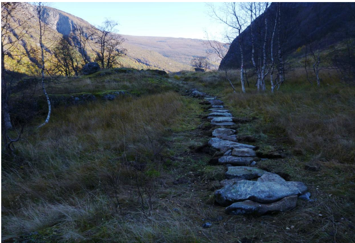
Figur 18. Steinlegging av stien frå Kilen til Likholemyra er utført av Sherpa og arbeidet er leia av Luster kommune og nasjonalparkforvaltar..
