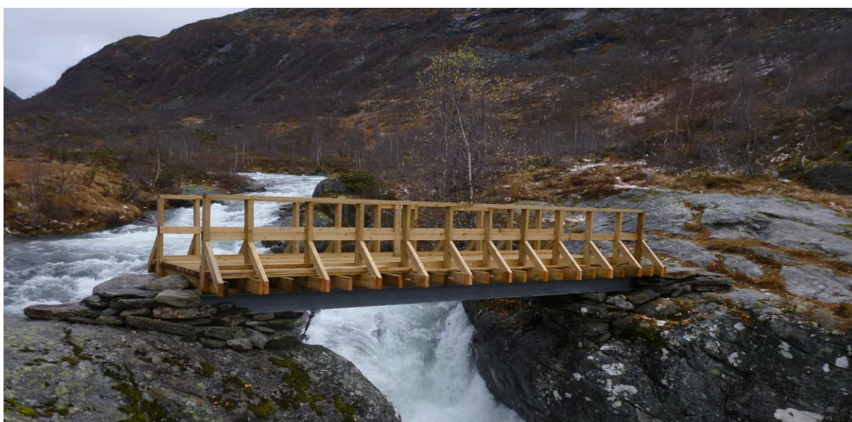
Figur 19. Ny bru over Vigdøla.
