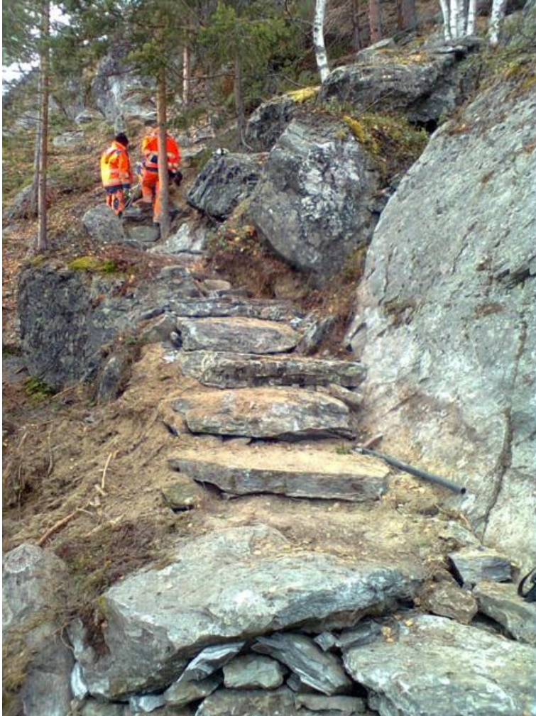
Figur 22. Arbeid med stigen nedre delar
