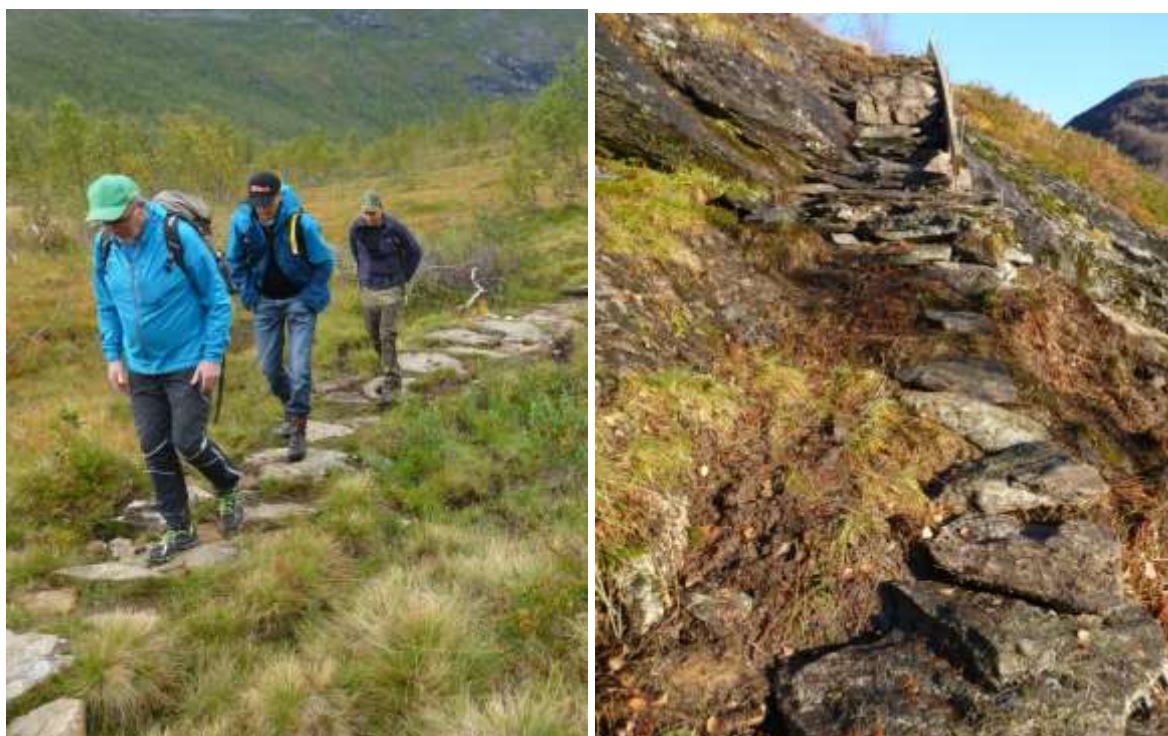
Figur 22. Utbetring av DNT stien med steinlegging. Muring av trapp opp Forlesvåi.
