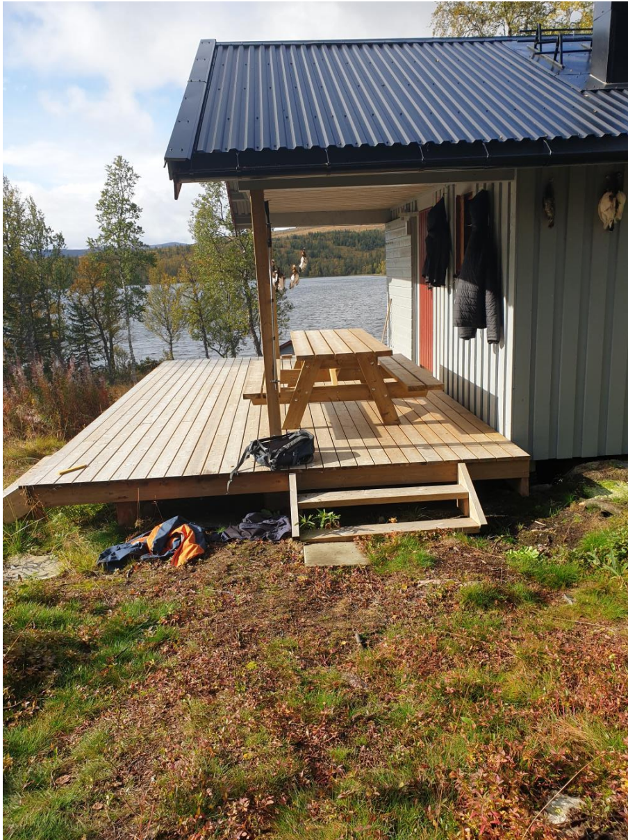
Fig. 1: Oversiktsbilde som viser verandaen ved Arvaslihytta.
