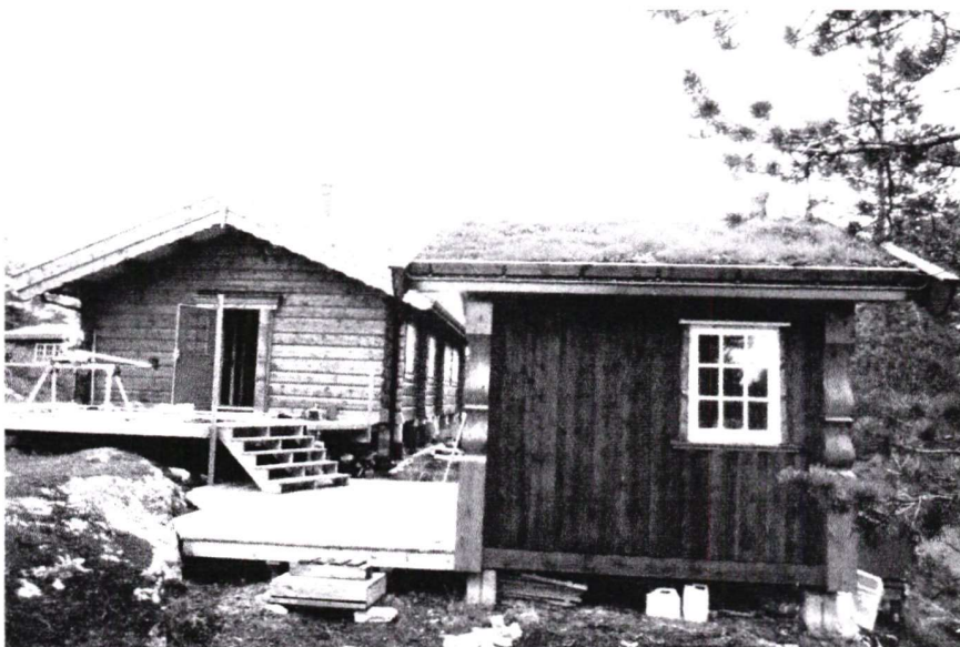
Platting vest og uthus under oppføring.
