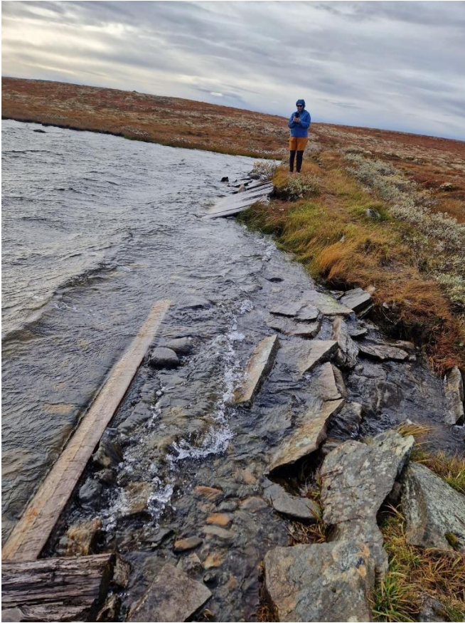
Figur 5 Oversiktsbilde (2) av dam Nedre Grønlitjønna
