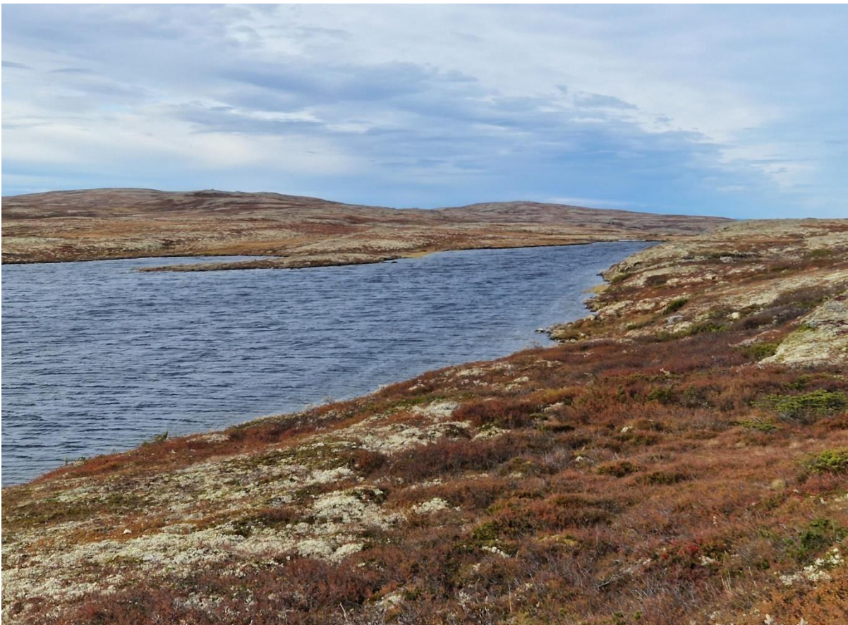
Figur 8 Oversiktsbilde av magasinet. Dam Nedre Grønli tjønna er plassert til høyre i enden av magasinet
