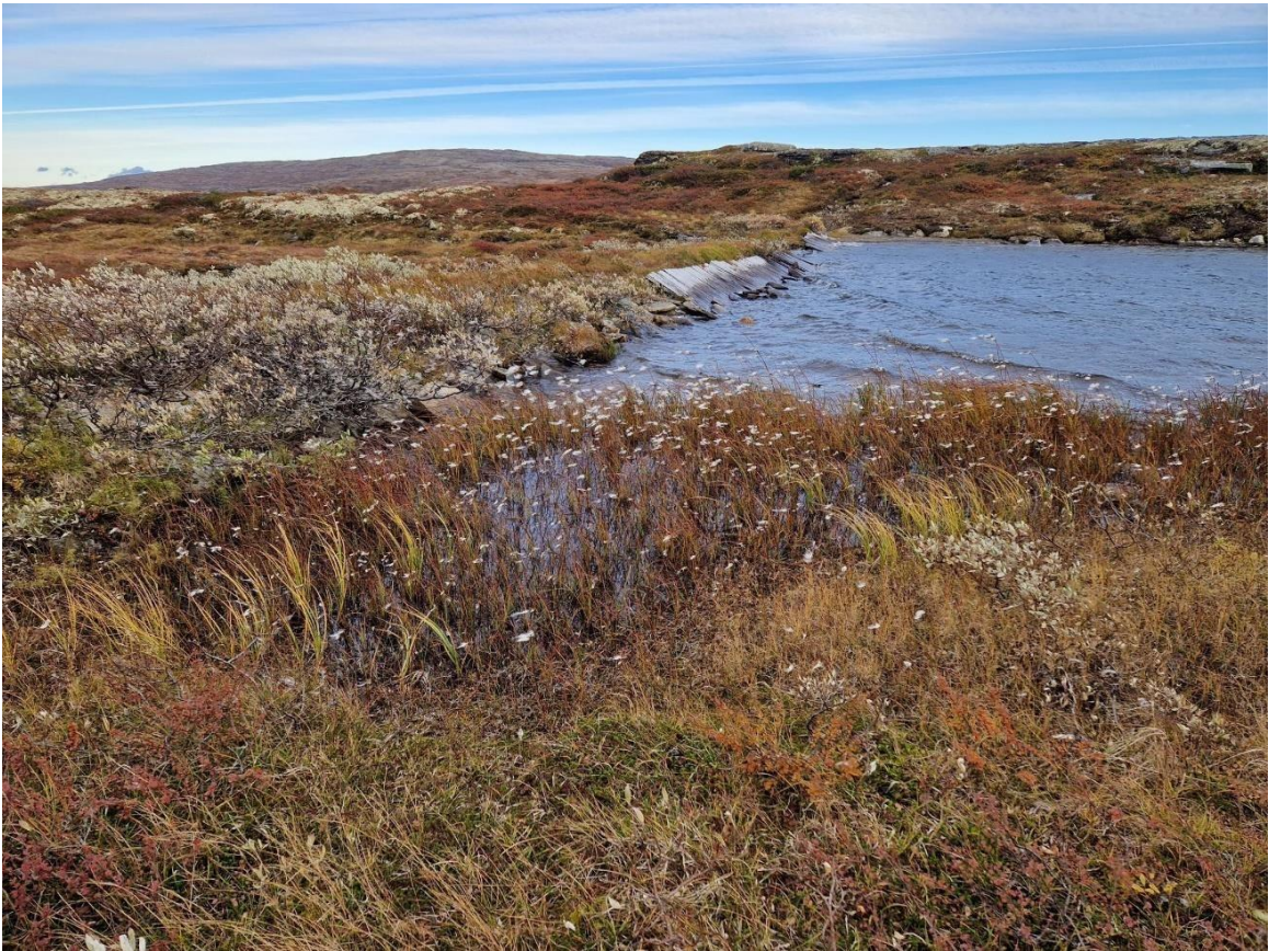
Figur 9 Oversiktsbilde (4) av dam Nedre Grønlitjønna
