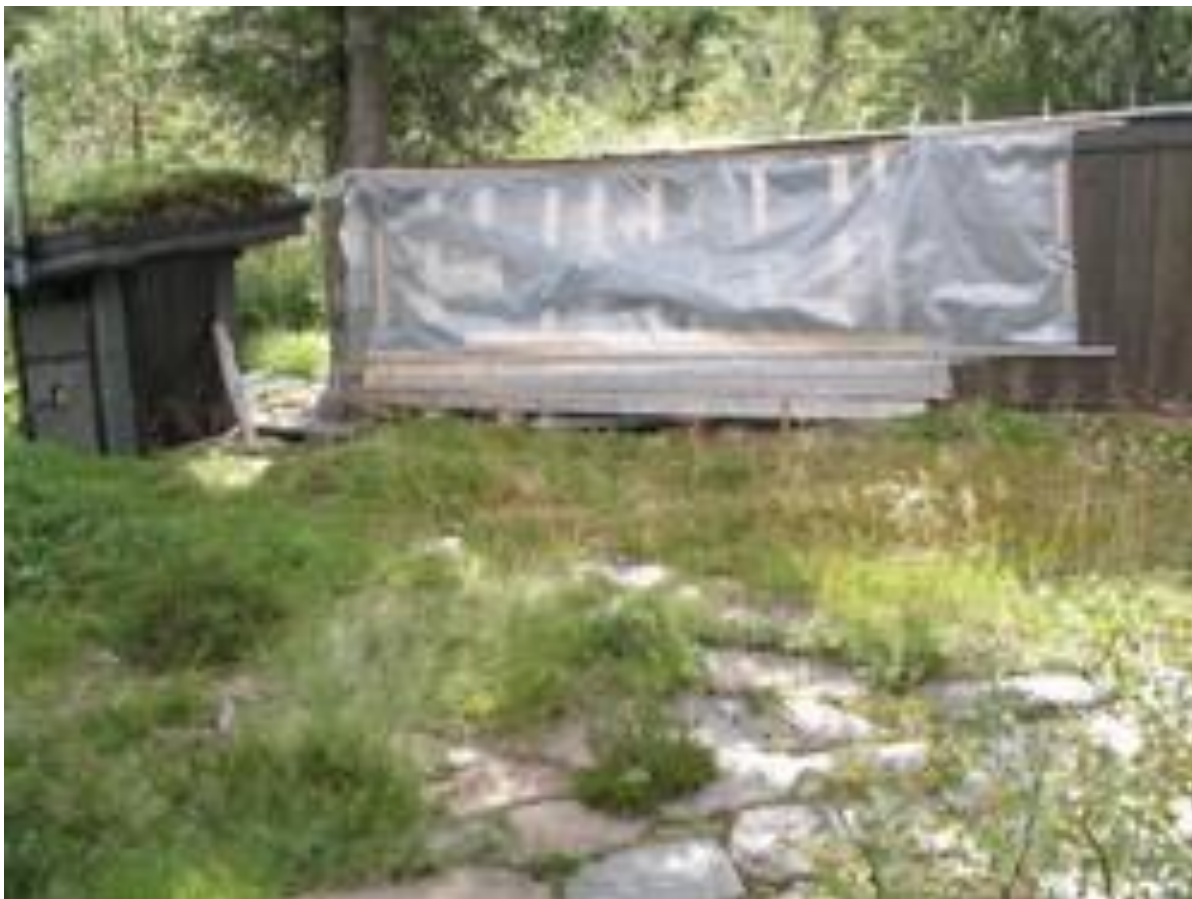
Fig. 3: Bilde av aggregatskjul og vedskjul tatt 31. august 2006 ©Statens naturoppsyn
