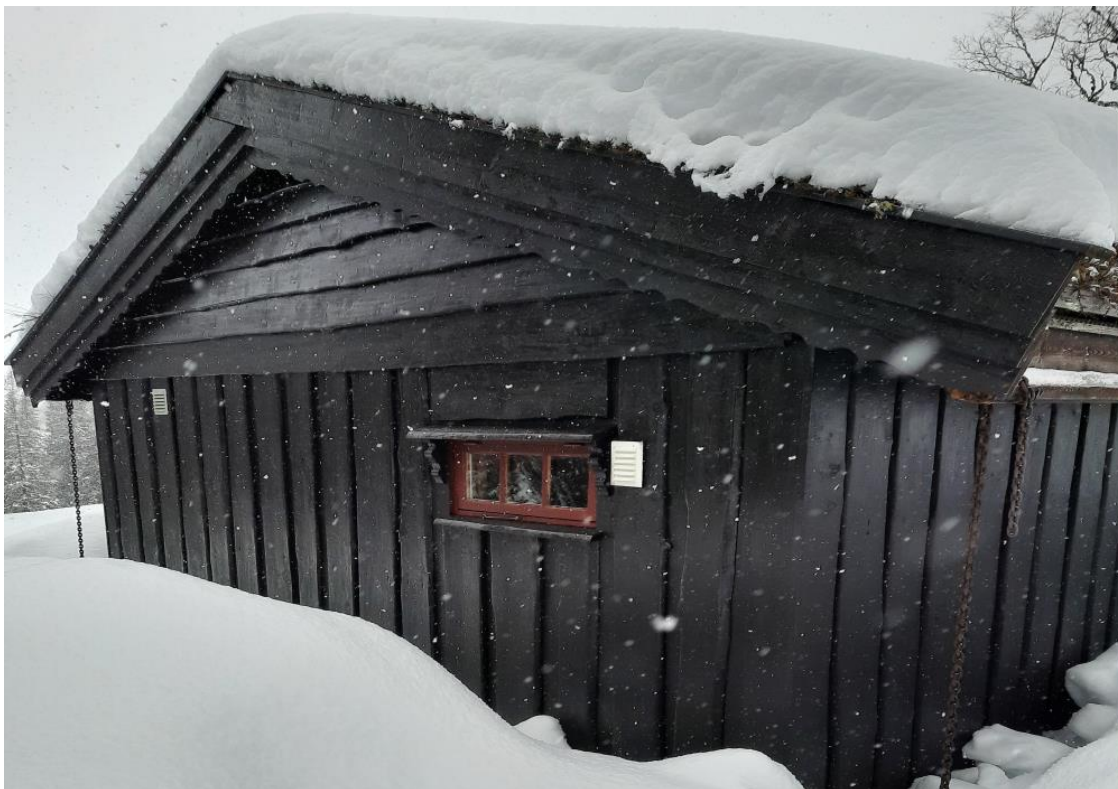
Fig. 1: Bilde 1 Vindu til soverom
