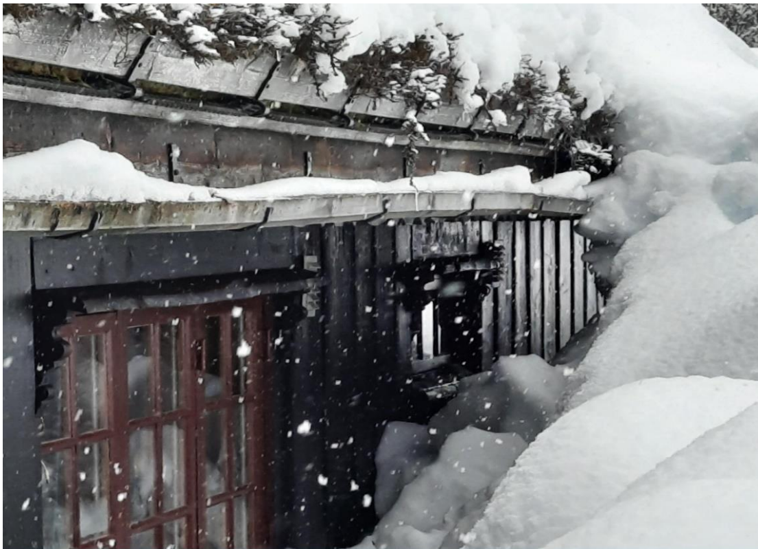
Fig. 2: Bilde 2 Vindu soverom til høyre i bildet.
