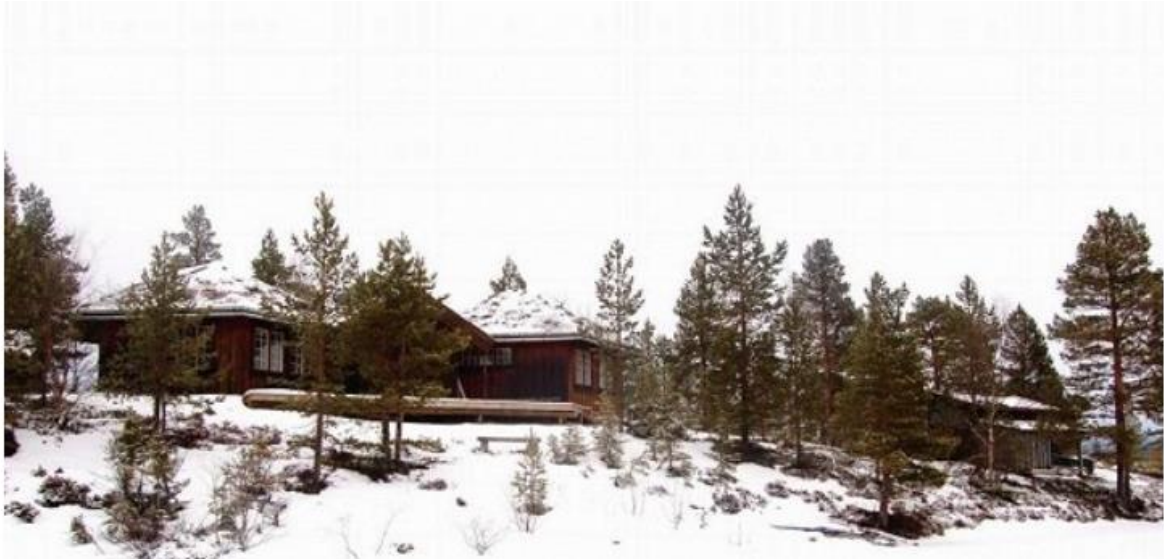
Fig. 1: Bilde av plattingen i tilknytning til hytte Skjellivatnet 3 med Gnr/Bnr/Fnr 156/3/46 i Steinkjer kommune.
