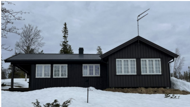
Bilde som viser østvendt fasade. Nytt omsøkt vindu er som de minste på dette bildet (120x110). Bildet er hentet fra en kontroll gjort av SNO 23.06.22.
