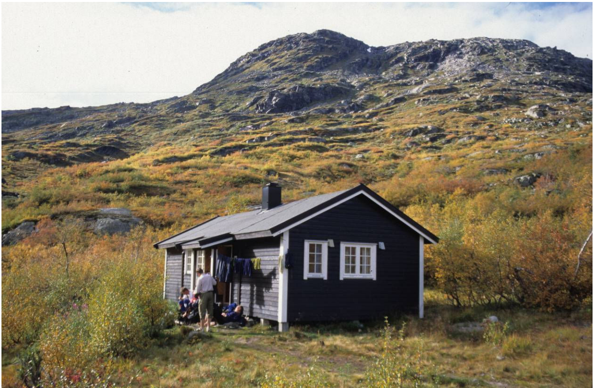
Sikringshytta etter 1. utbygging. Bilde sett mot NV. Foto: Sverre A. Larssen
