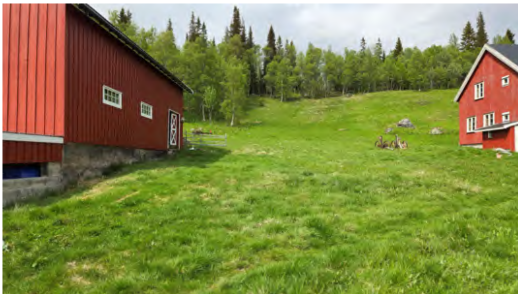
Figur 4: Låven til venstre i bildet og våningshuset til høyre.
