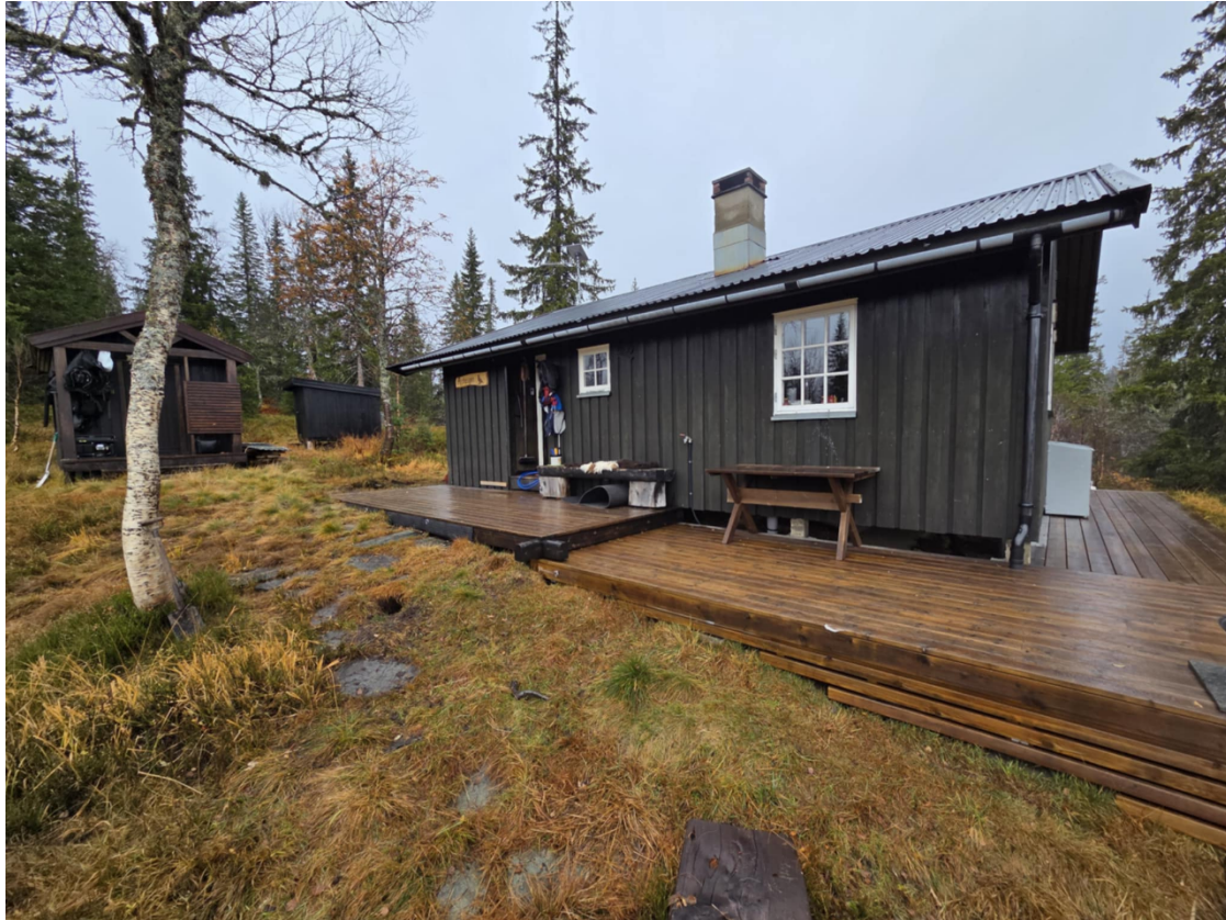
Figur 2 Det ønskes å flytte inngangspartiet fra denne vegg til vestsiden av hytta, og erstatte dagens dør med et nytt vindu. I tillegg ønskes det å sette inn en balkongdør på denne delen av bygget.
