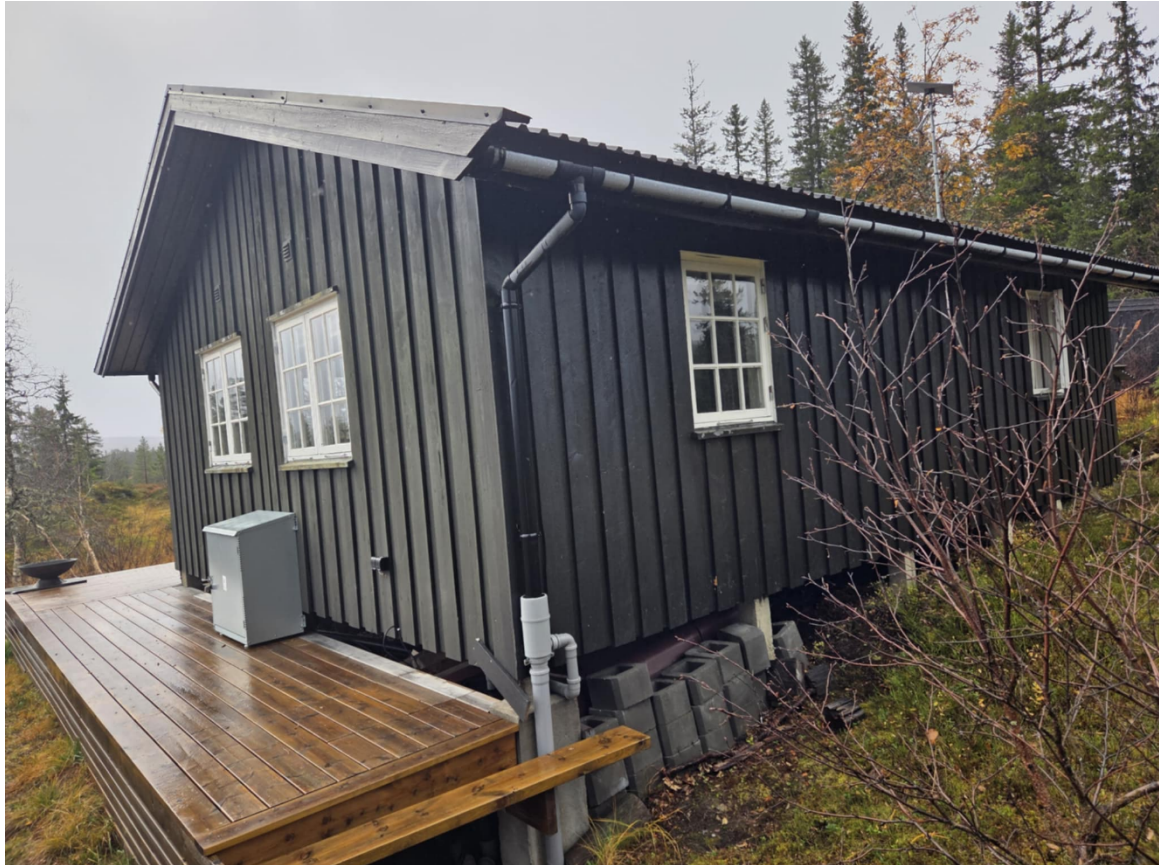
Figur 4 Hytta fra øst. Vinduene på den østlige vegg (kortenden) ønskes skiftet ut med fire større vinduer, målt til 1000 \times 1800 mm, uten sprosser.
