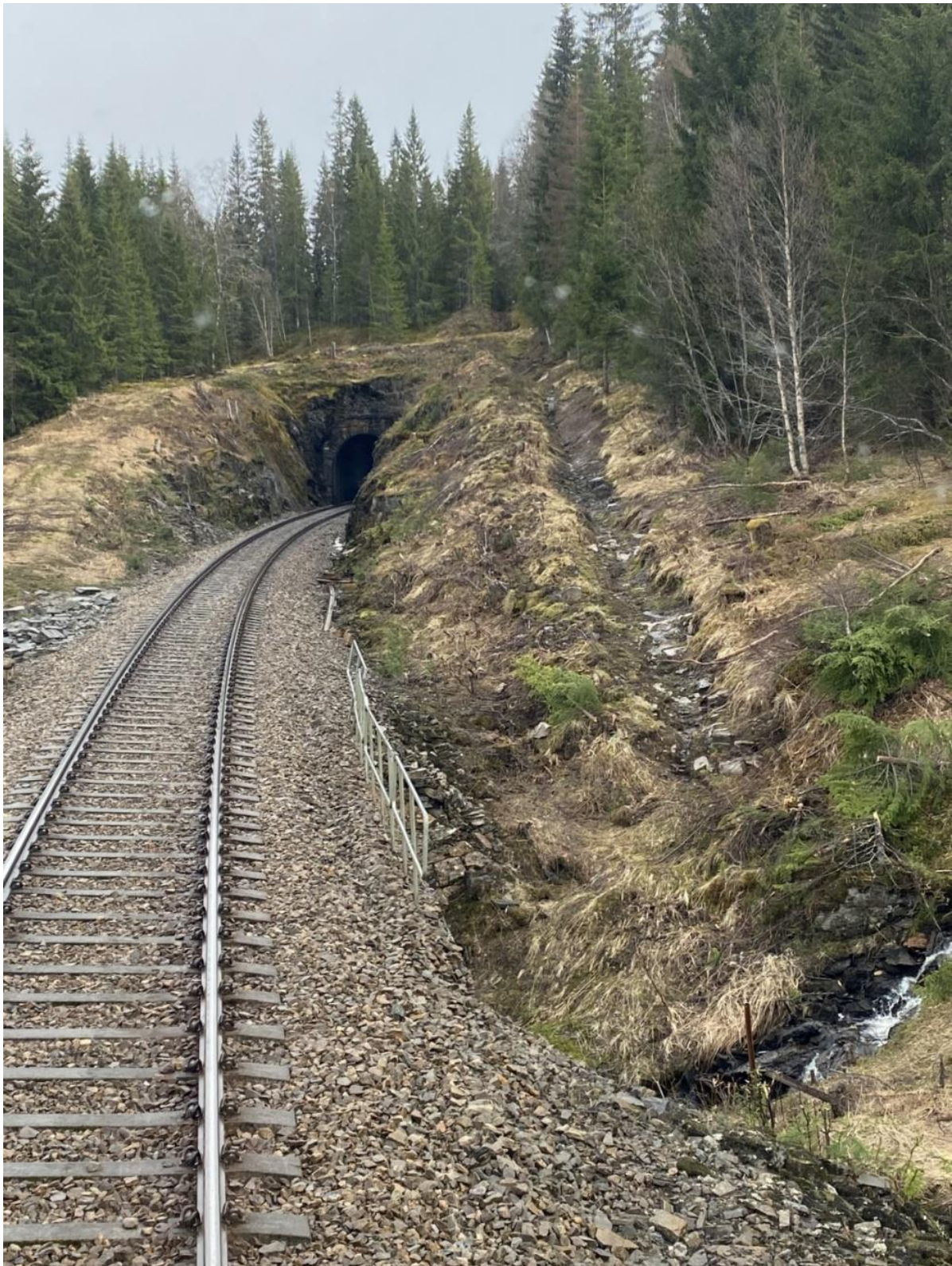
Figur 4 Bilde som viser eksempel på tunneltak som kan benyttes som viltovergang. Tunneltaket er her ryddet noe for skog. Dette for å gjøre framkommeligheten bedre for dyr (Pedersen 2025)
