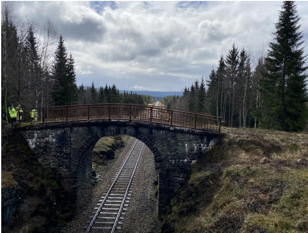
Figur 6 Bilde som viser vei over jernbane med mulighet for kyssing av jernbanen for dyr (Pedersen 2025).
